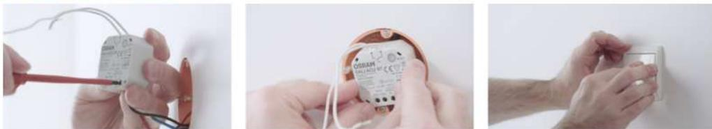
L'installation est simple, le module s'encastre dans la boîte d'encastrement.
